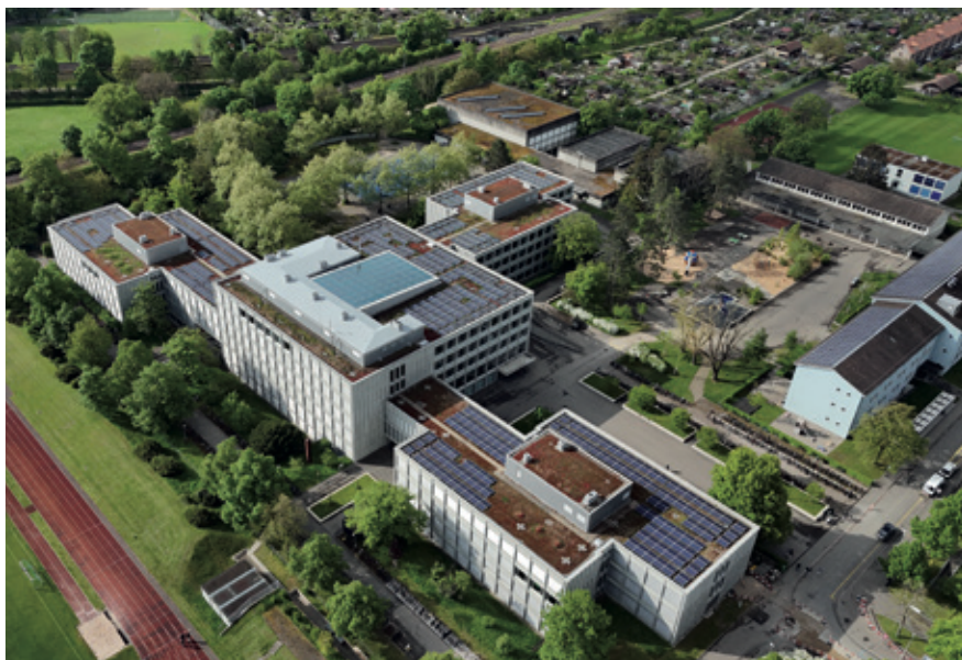
Photo: Gymnase Bäumlhof Bâle
